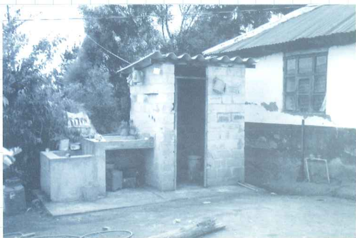
Una unidad sanitaria completa, cerca de la casa
