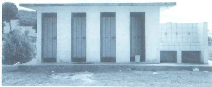
La batería Sanitaria de la escuela
